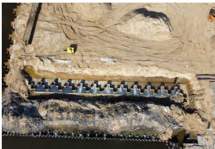
Fot. Nabrzeże w trakcie prowadzonych prac budowlanych, autor: Tomasz Majka, STRABAG
