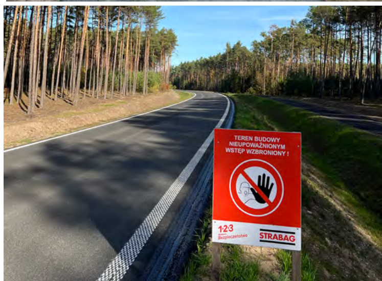
Fot. prace przy układaniu nawierzchni oraz gotowy odcinek drogi.
