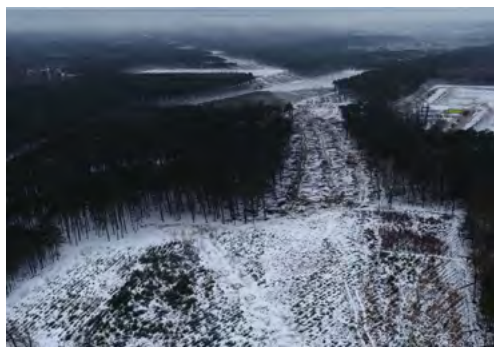
Fot. Postępy prac na budowie Południowej Obwodnicy Zielonej Góry
