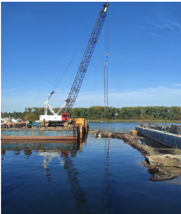
Fot. Prace hydrotechniczne na nabrzeżu
